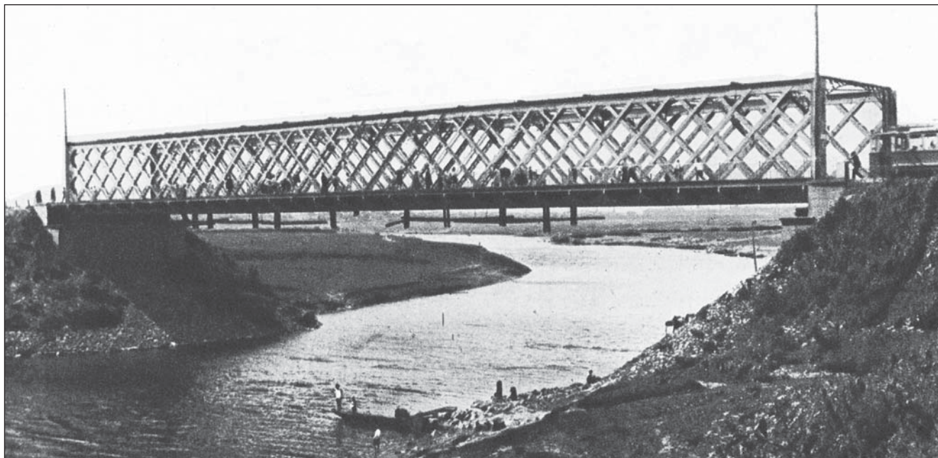
Американский мост через реку Которосль. Ярославль. 1929 год.
