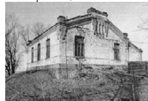
Насосная станция. Помещение для насоса. Фото 2000 г.
