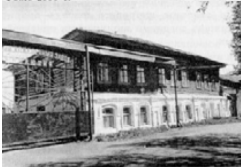
Производственный корпус 2-й пол. 19 в. Фото 2000 г.
