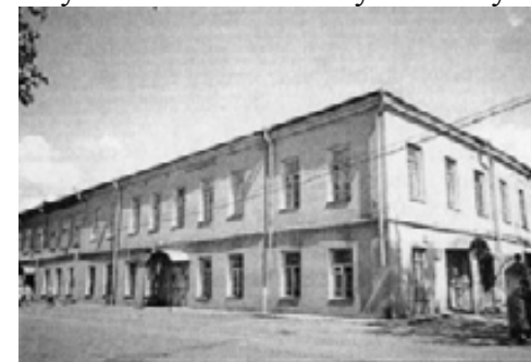
Уездные присутственные места. Главный корпус. Фото 2001 г.
