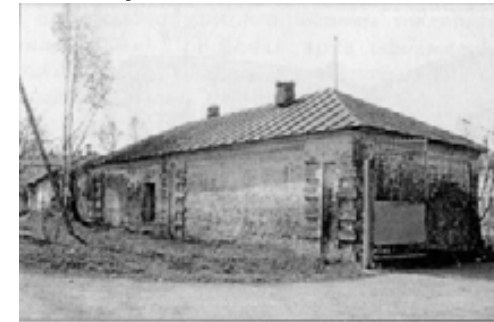
Хозяйственный корпус. Фото 2000 г.
