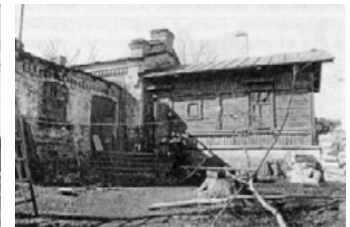
Насосная станция. Жилая часть. Фото 2000 г.
