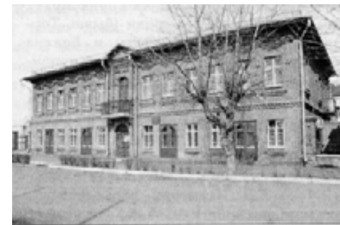
Дом жилой. Фото 2000 г.
