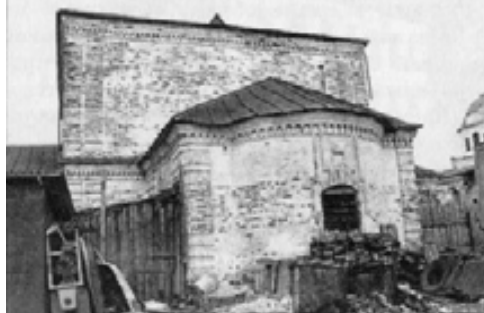
Вид с юго-востока. Фото 2000 г.
