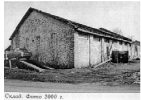
Склад. Фото 2000 г.
