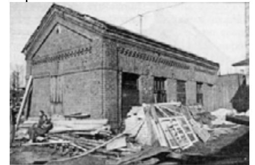
Насосная станция. Фото 2000 г.
