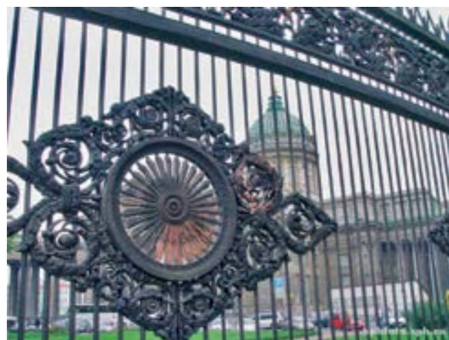
Звенья чугунной ограды отлиты по рисунку А.Воронихина. Деревянную модель выполнил резчик В. Захаров.
