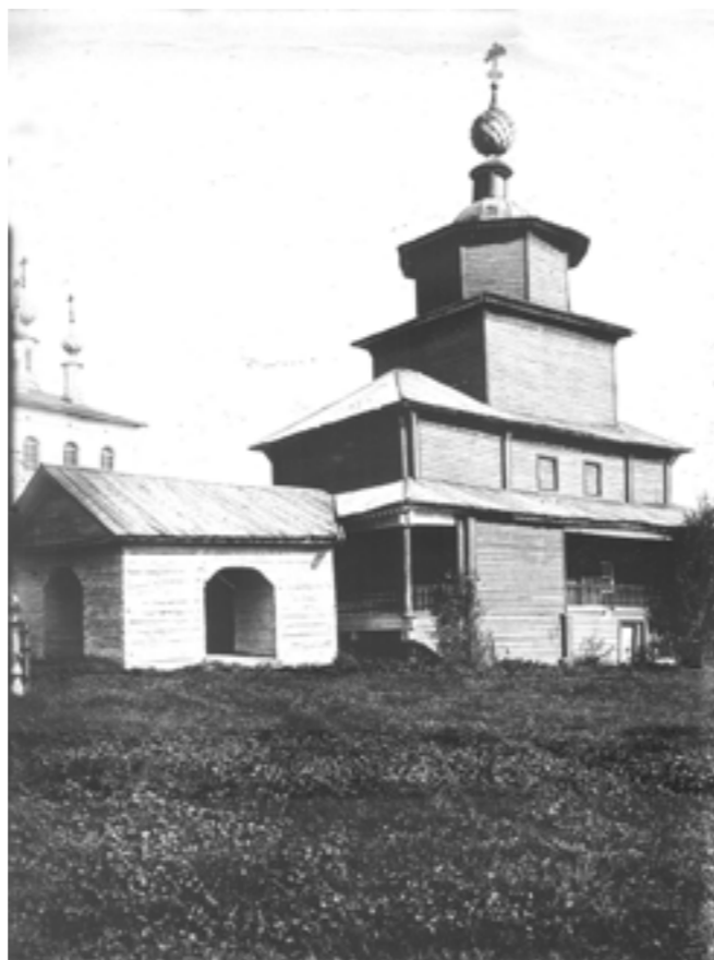
Церковь Преображения Господня 1768 г. постройки в с. Коровново Солигаличского уезда.
