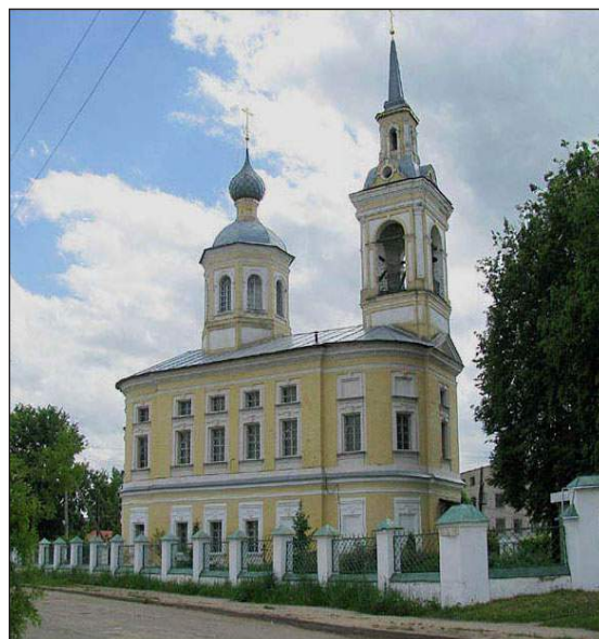
Церковь Преображения Господня в Нерехте. Построена по проекту С.А. Воро- тилова в 1780-е гг.
