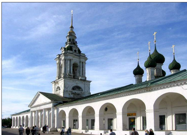
Красные ряды и церковь Спаса в рядах в Костроме Построены в 1790-е гг. по проекту С.А. Воротилова
