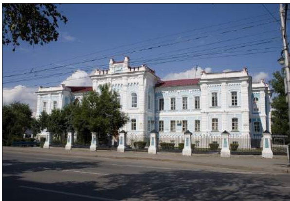
Здание Александровского реального училища в Тюмени (открыто в 1879 г., ныне - Государственная сельскохозяйственная академия)
