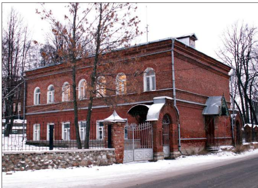
Учительский дом ремесленной школы К.А. Попова (ныне административное здание БВЛ «Большие Соли»). Фото В. Королева
